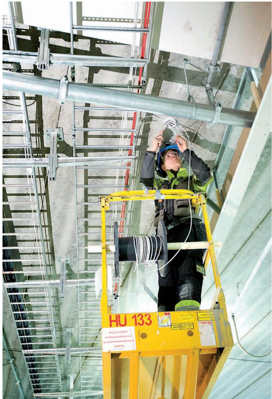
Sähköasentaja Matti Määttä ahkeroi korkeuksissa. Parhaimmillaan asentajia on ollut kolmisenkymmentä.
