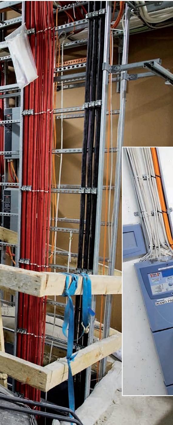
Mikko Rantala asentaa kaapelihyllyjä kauppakeskuksen rakennustyömaalla.
